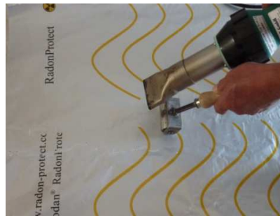
RadonProtect Folie, mit Heißluft verschweißen
